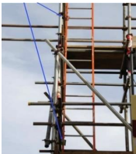
ມັດຂັ້ນໄດ ໃສ່ດ້ານເທິງ ແລະ ດ້ານລຸ່ມ ຕາໜ່າງອ້ອມຕົກປ້ອງກັນສິ່ງຂອງຕົກໃສ່ ໃສ່ສາຍຮັດນິລະໄພ ຕັ້ງເສົາຮ້ານນັ່ງ ໃຫ້ຕັ້ງສາກກັບພື້ນທີ່ພຽງ ແລະ ມັດຕິດຕົກໃຫ້ແໜ້ນ
