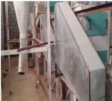
ຕິດຕັ້ງເຄື່ອງປ້ອງກັນບໍລິເວນທີ່ເປັນອັນຕະລາຍ
