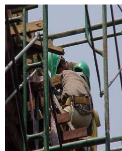
ມັດຂັ້ນໄດ ໃສ່ດ້ານເທິງ ແລະ ດ້ານລຸ່ມ ຕາໜ່າງອ້ອມຕົກປ້ອງກັນສິ່ງຂອງຕົກໃສ່ ໃສ່ສາຍຮັດນິລະໄພ ຕັ້ງເສົາຮ້ານນັ່ງ ໃຫ້ຕັ້ງສາກກັບພື້ນທີ່ພຽງ ແລະ ມັດຕິດຕົກໃຫ້ແໜ້ນ
